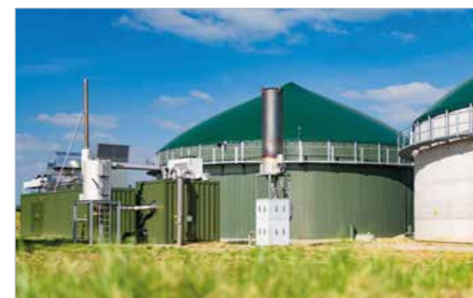
Génération de chauffage urbain
